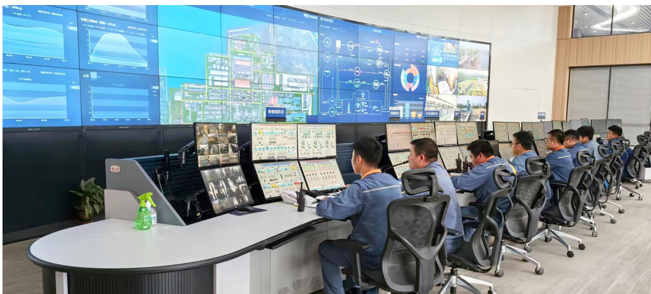
湛江钢铁水控中心工作场景 / 誉建业 摄
