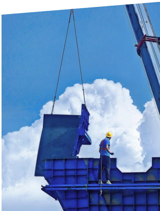
汕头市城际铁路龙华段施工现场，一名工人正在指挥吊车。/ 曾越 摄
