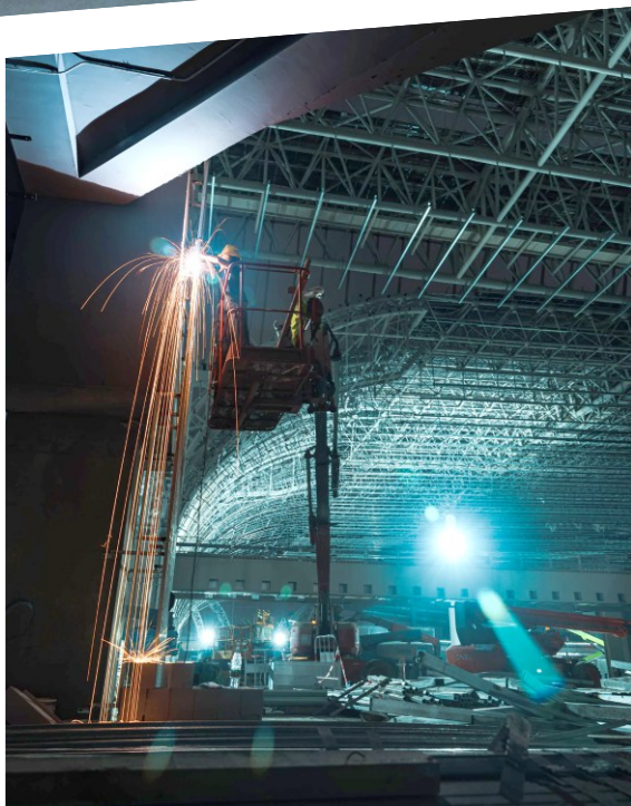
广州白云站工程，工人正在焊接。/ 简志成 摄
