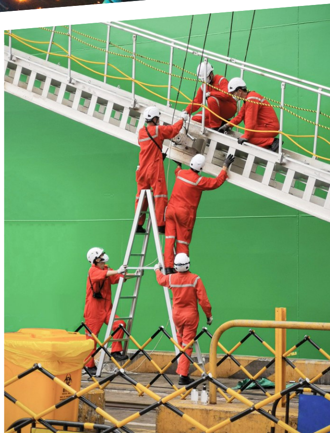
港口工程人员在紧急维修船舶的舷梯。/ 王少斌 摄
