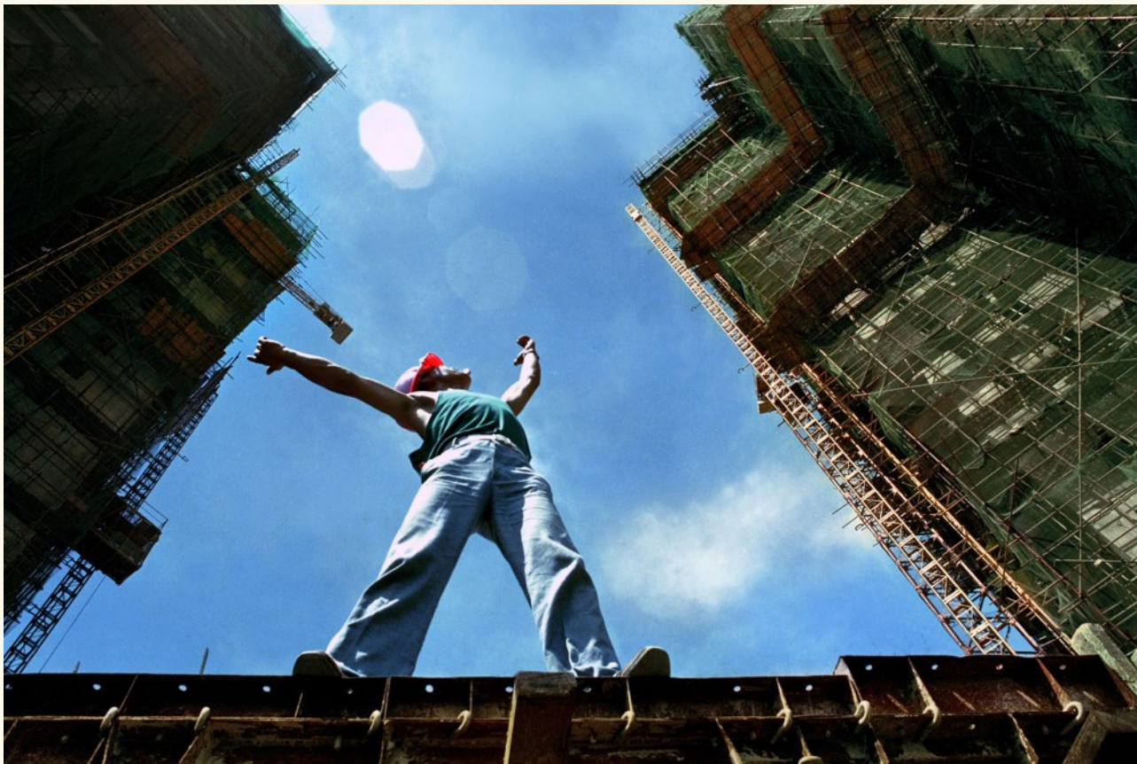
《升》，周顺斌 1984 年摄于深圳红岭大厦工地。
