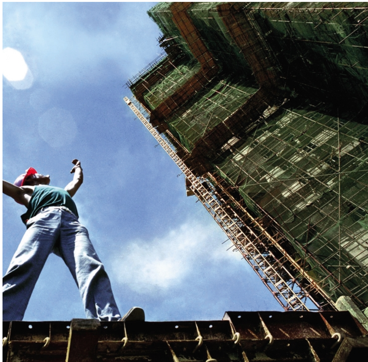
《升》/周顺斌 1984 年摄于深圳红岭大厦工地。
